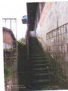
Figura 3: Escadaria de acesso ao imóvel.
